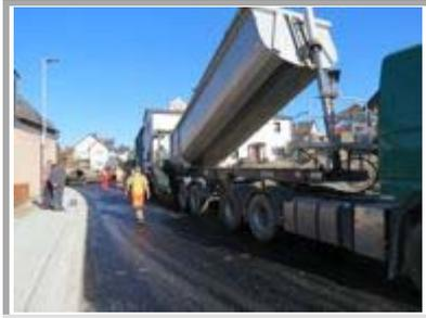
*Die Bauarbeiter ziehen die Deckschicht auf die Issigauer Ortsdurchfahrt; diese bleibt bis Ende November gesperrt.*
